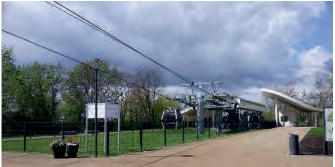
Seilbahn Berlin Hellersdorf, Zwischenstation »Kienberg«
