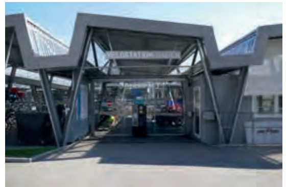
Abbildung 53: Velostation an einem Fernverkehrsbahnhof (Baden, CH)
