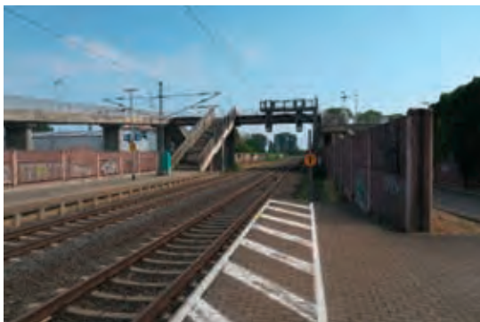
Abbildung 18: Rodenbach Bhf am Lärmschutz
