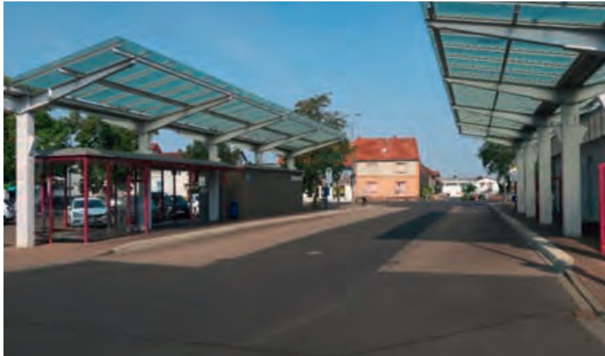
Abbildung 30: Integrierte Umsteigehaltestelle im Zentrum von Somborn
